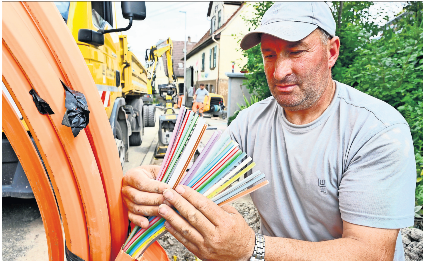
Die Bauarbeiten in Höpfigheim neigen sich schon langsam dem Ende entgegen.
